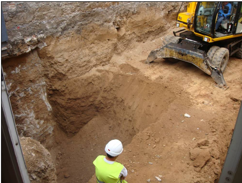
Imatge 14: Procés de rebaix
