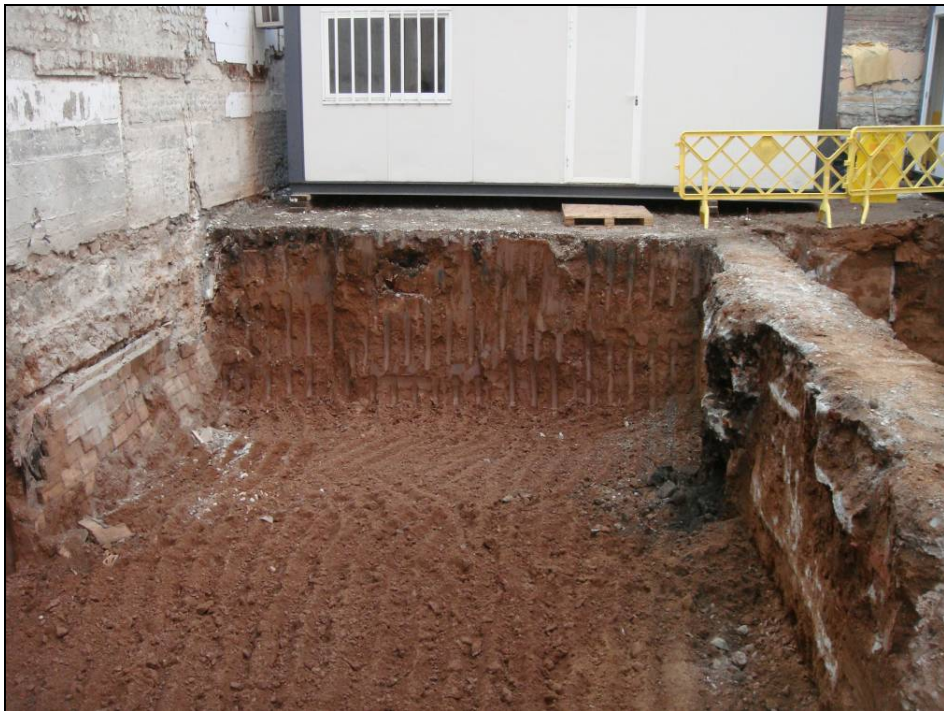
Imatge 4: Procés de rebaix
