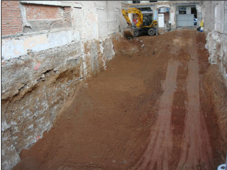
Imatge 17: Final rebaix del solar.
