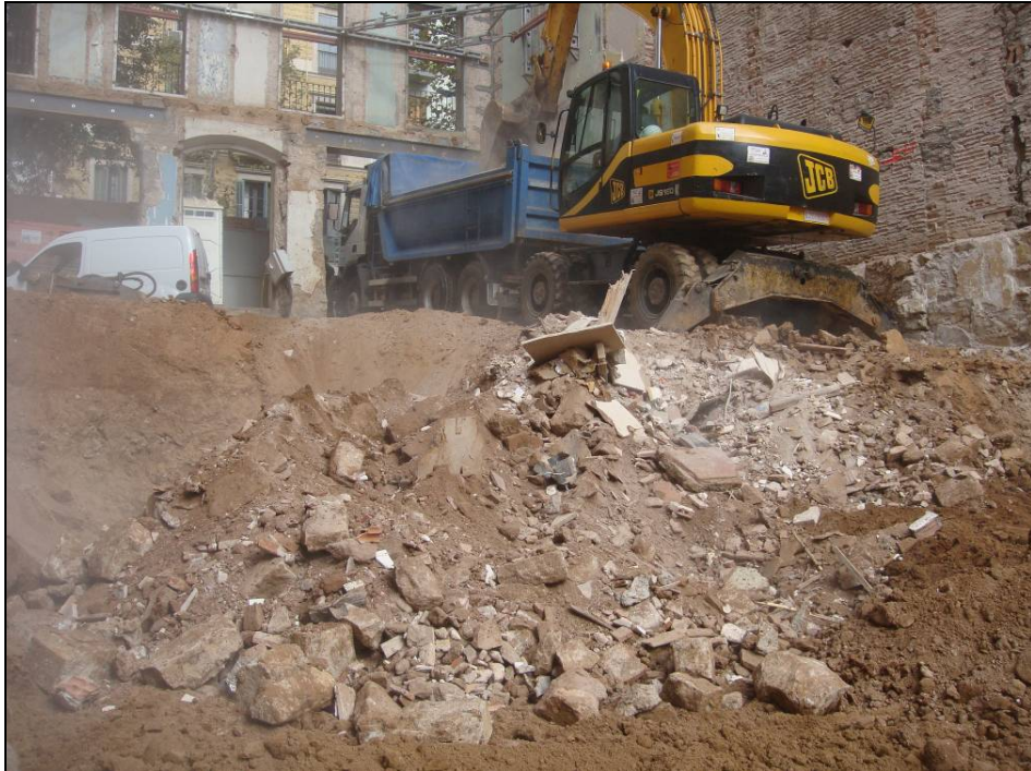
Imatge 15: Extracció de l'enderroc
