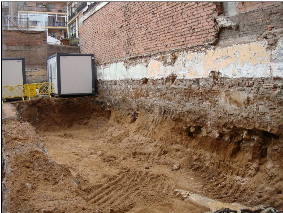
Imatge 10: Procés de rebaix
