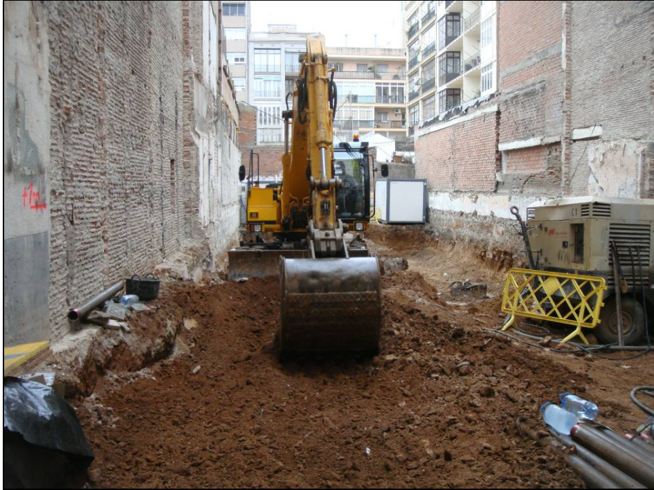
Imatge 11: Adequació de la rampa
