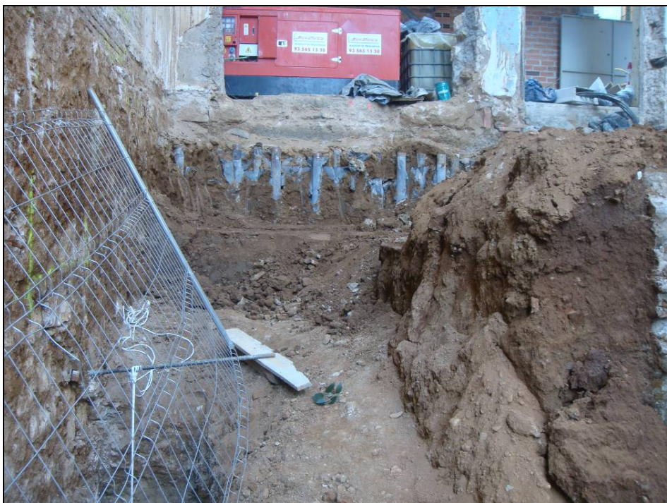
Imatge 22: Rebaix de la banda nord-est del solar
