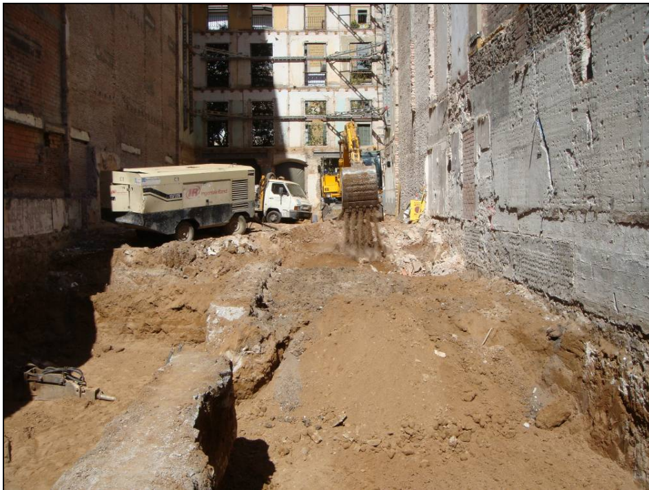
Imatge 6: Procés de rebaix
