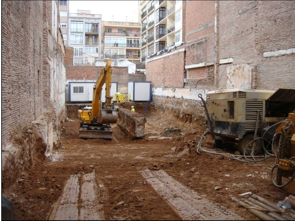
Imatge 13: Adequació de la rampa
