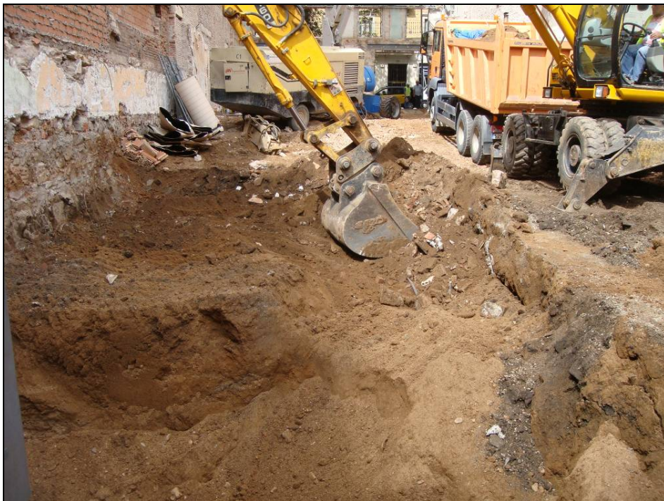
Imatge 2: Inici del rebaix del solar
