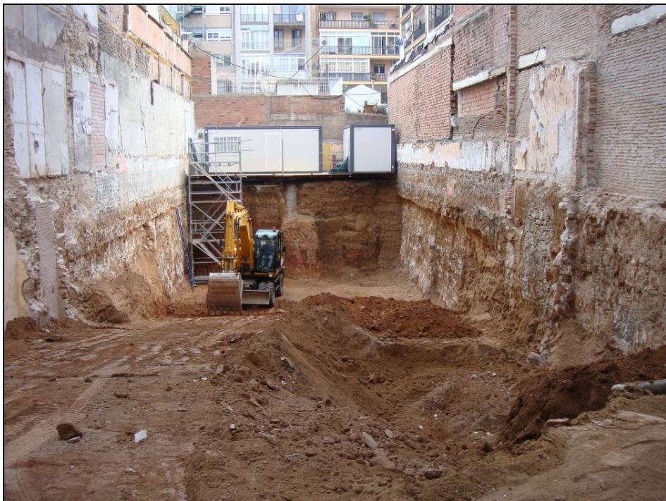
Imatge 16: Rampa d'accés per camions
