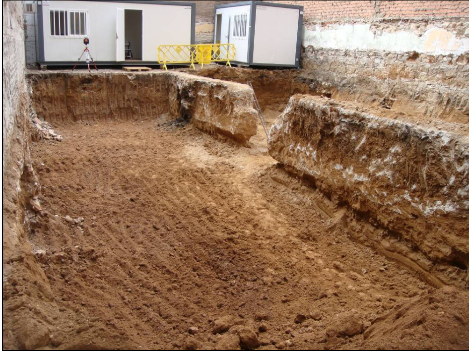
Imatge 9: Procés de rebaix
