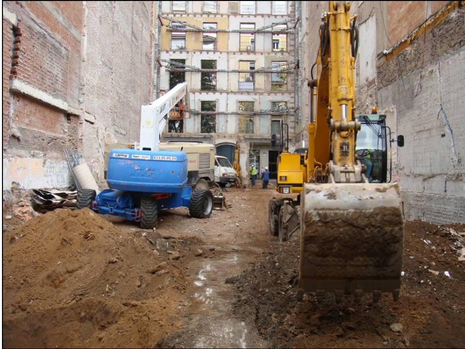
Imatge 1: Inici del rebaix del solar
