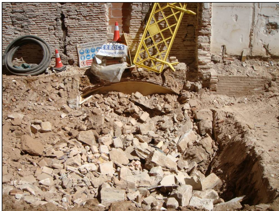
Imatge 8: Reompliment d'enderroc del soterrani
