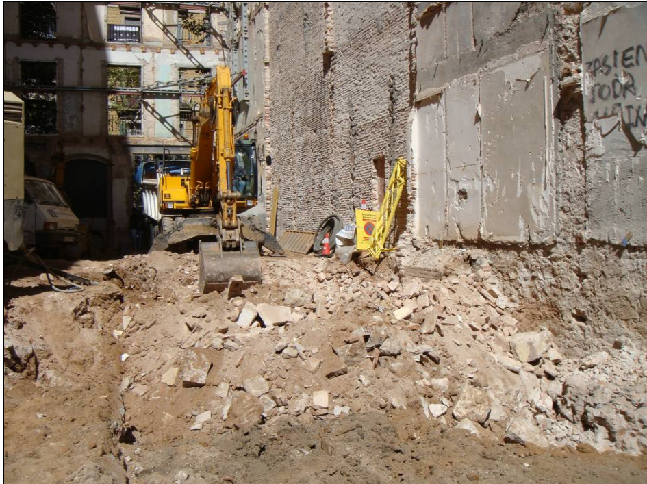
Imatge 7: Reompliment d'enderroc del soterrani
