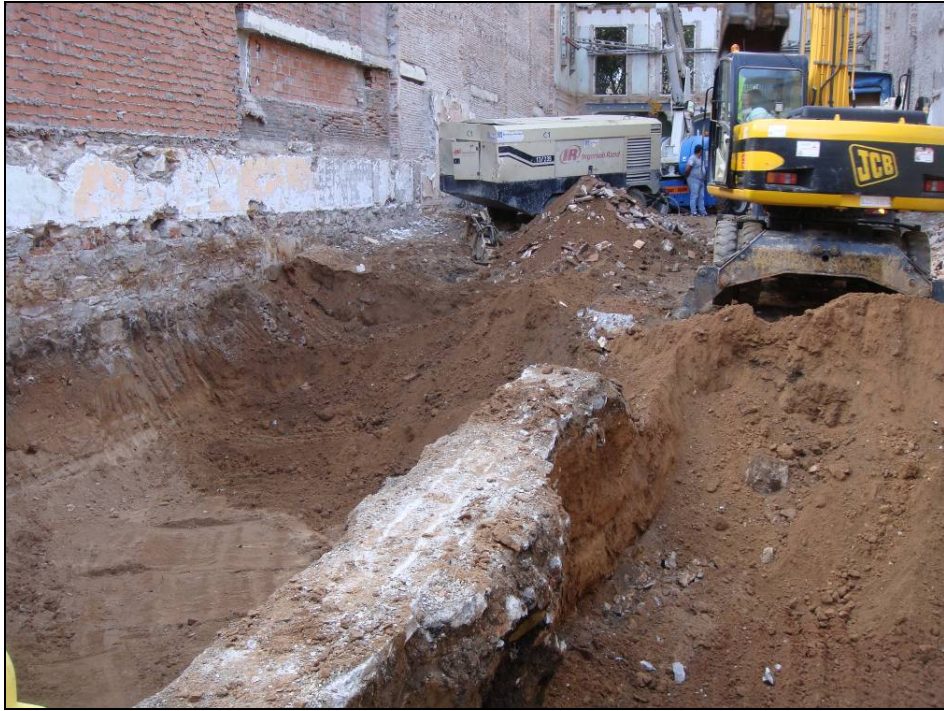
Imatge 3: Procés d'excavació
