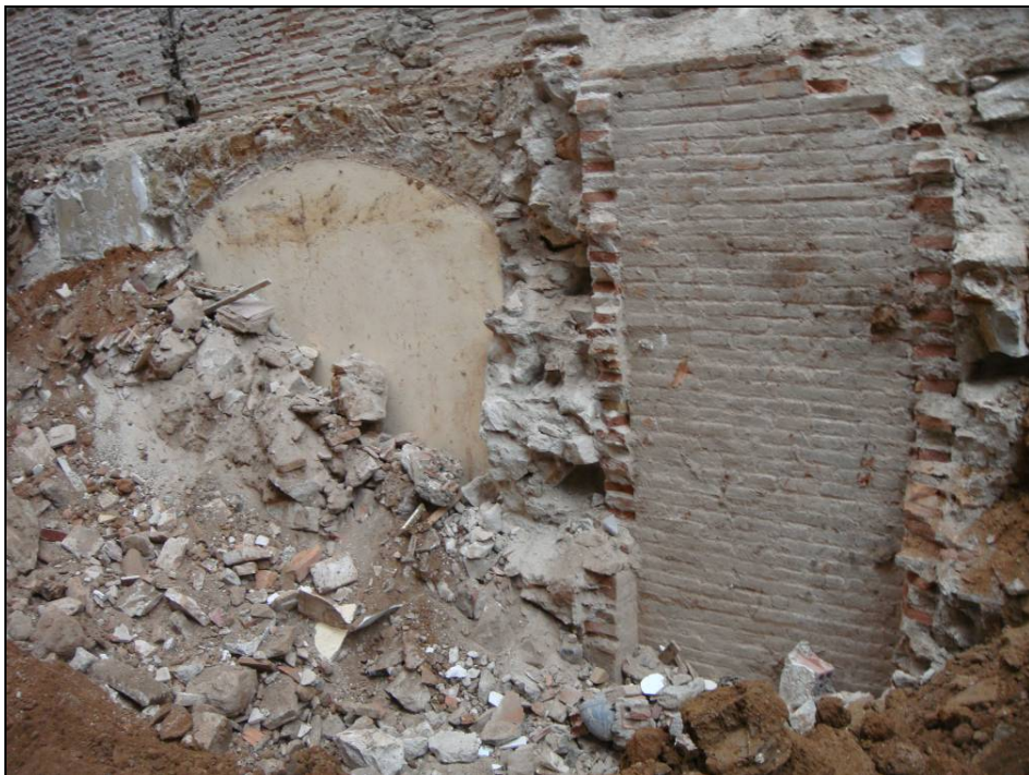
Imatge 12: Reompliment d'enderroc del soterrani
