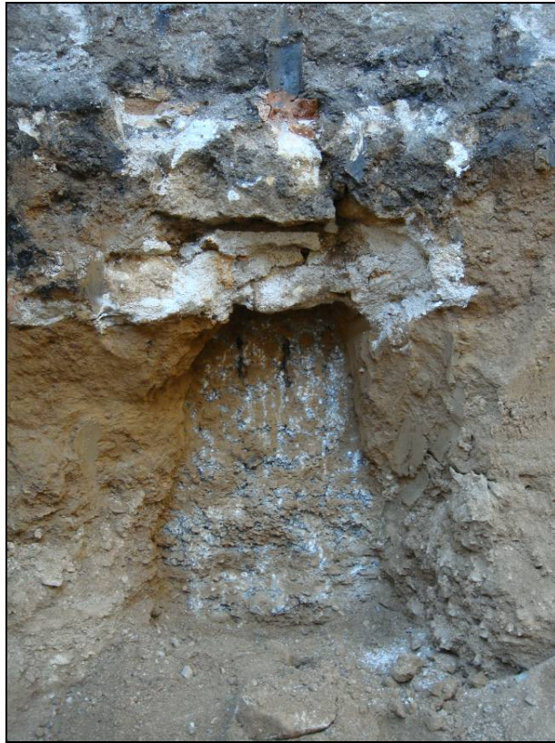
Imatge 5: Reforç de la fonamentació de formigó
