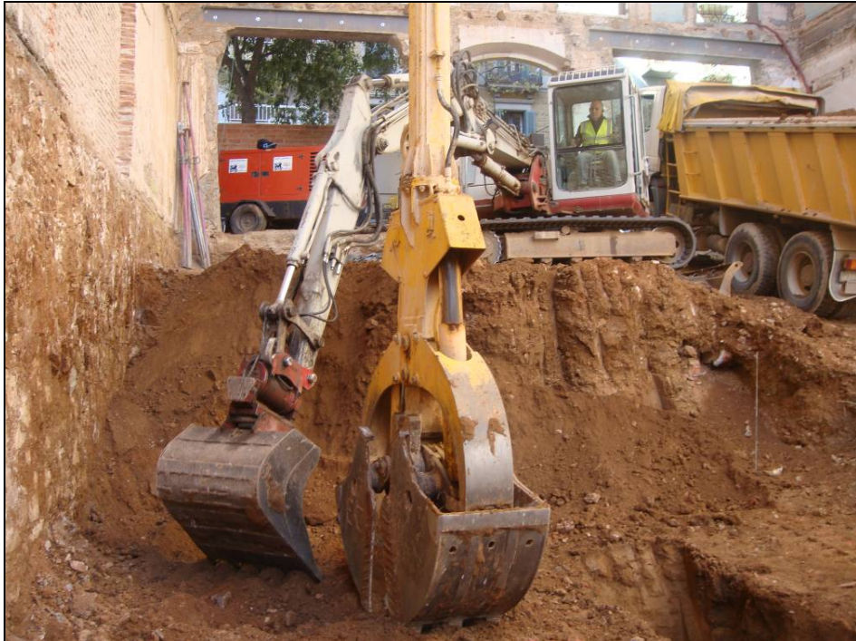
Imatge 21: Rebaix de la banda nord-est del solar
