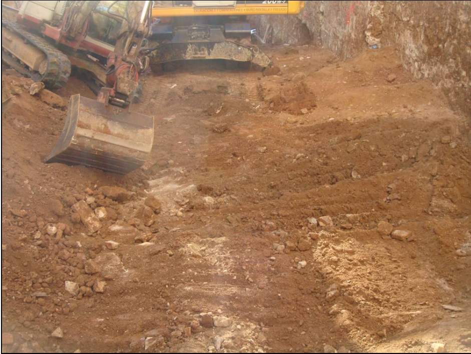
Imatge 23: Adequació de la rampa
